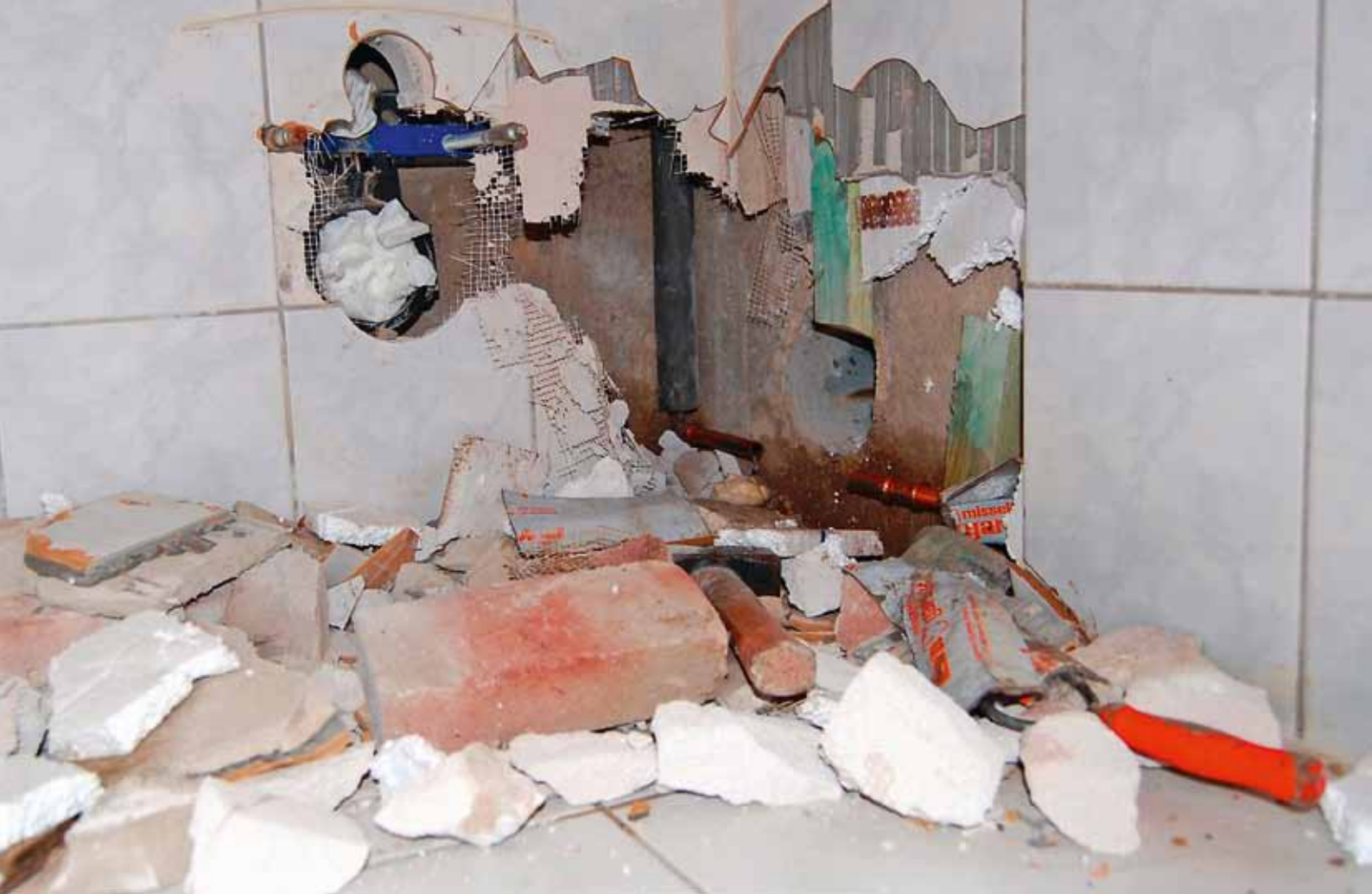
Ein traditionell per Austausch der Rohrleitung sanierter Leitungswasserschaden kann für die Bewohner zu einer nervlichen Zerreißprobe ausarten. Bild: HDI Gerling
