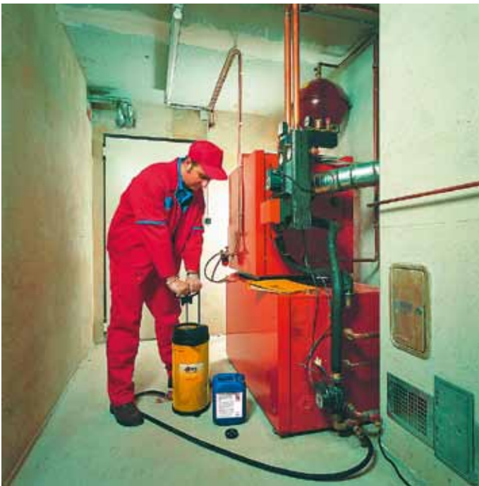
Das Abdichtverfahren in der Praxis: links an einer Trinkwasseranlage, rechts an einer Heizungsanlage. Bild: BaCoGa
