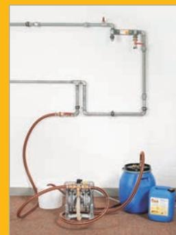
3. Dopo aver eseguito e terminato a regola d'arte il riempimento si deve pressurizzare la tubatura a 4 bar, aggiungendo eventualmente 1 bar per ogni 10 m di altezza dell'installazione da sigillare. In questo modo il sigillante viene pressato nei raccordi filettati non stagni.
