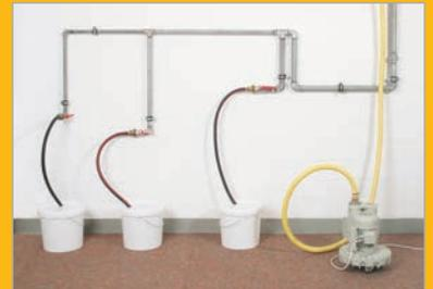
BCG Gas 2000 conserva il suo stato viscoso anche dopo l'essiccazione. Al termine delle operazioni si deve eseguire una prova di tenuta secondo DVGW-TRGI 2008.
