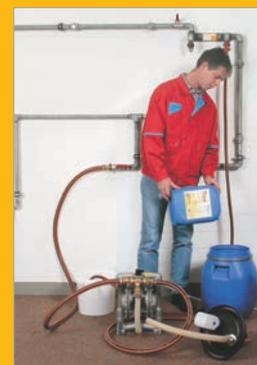
2. La rete di tubature deve essere accuratamente disaerata mediante i rubinetti d'arresto montati al posto degli apparecchi a gas e iniziando dal punto più basso – ovvero del rubinetto di arresto più vicino al punto di erogazione – fino ad arrivare al rubinetto più alto e più lontano.
