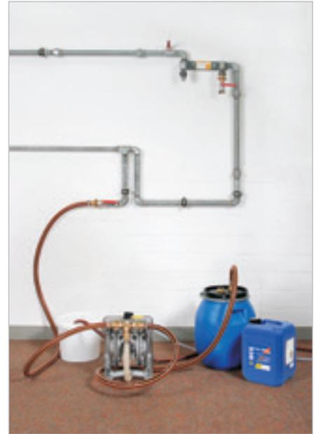
**3.** Nach ordnungsgemäßer Befüllung ist die Leitung mit 4 bar zuzüglich 1 bar je 10 m Höhe der abzudichtenden Installation zu beaufschlagen.
