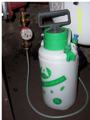
Bild 15 – Anschluss zur Bestimmung der Größe der Medienleckage
