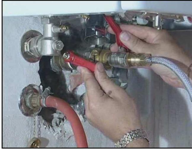
**Bild 44** – Druckschlauchanschluss zur Armatur mit den Schnellverbindern für Druckluft
