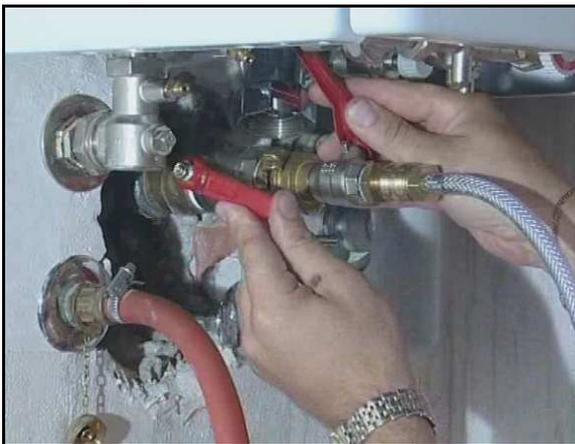
**Bild 29** – Anschluss der Druckluftzuführung zur Wartungsarmatur
