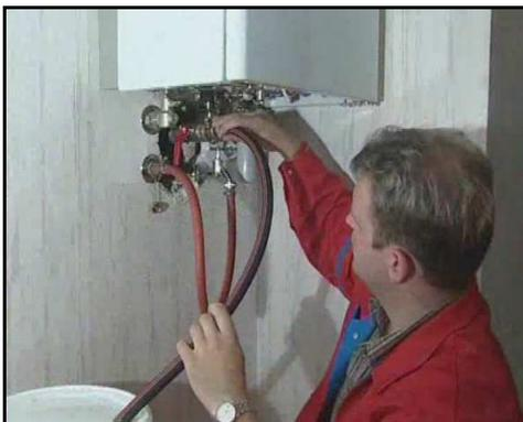
**Bild 48** – Anschluss vom Entlüftungsschlauch an die Wartungsarmatur
