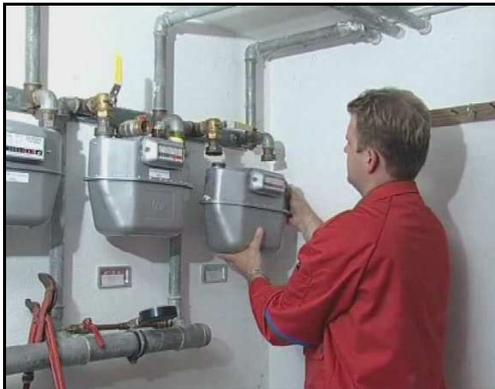
**Bild 23** – Gaszählerausbau
