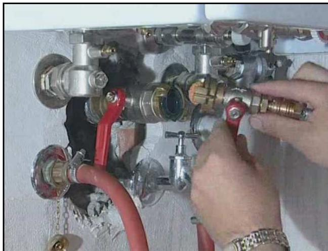
**Bild 46** – Anschluss der Armatur mit der Verbindung zum Druckluftanschluss (Stickstoff) und mit dem eingelegten Molch wird an die den Absperrhahn des Gasverbrauchers ersetzende Armatur angeschlossen.
