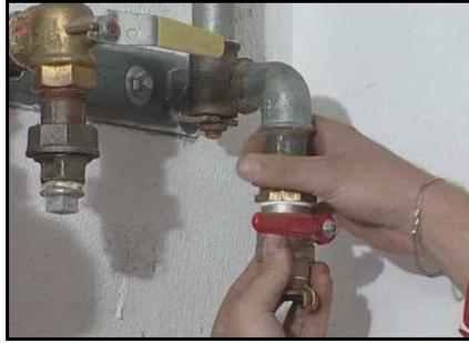
**Bild 25** – Einbau der Wartungsarmaturen an die Endstelle der Gasrohrleitung
