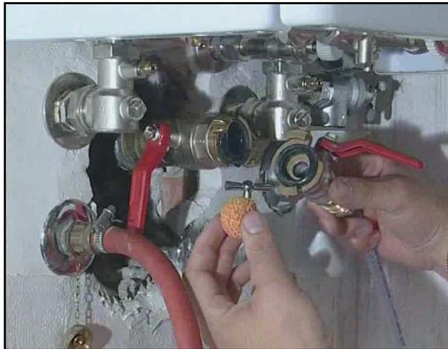
**Bild 45** – Molcheinlegen in die Armatur mit dem Anschluss an die Druckluft
