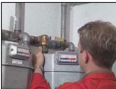
**Bild 53** – Gaszähleranschluss zur Gasrohrleitung
