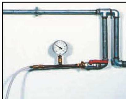
**Bild 27** – Druckprüfung
