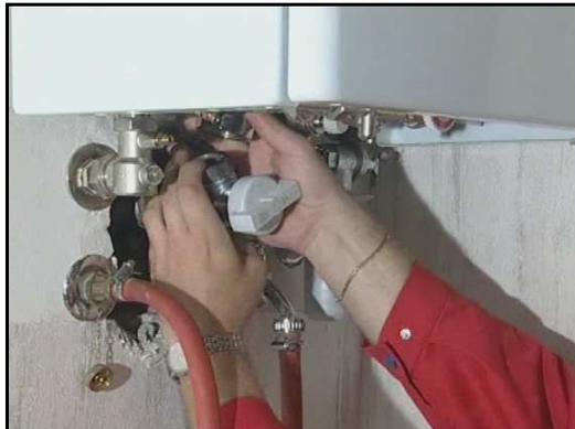
**Bild 24** – Ausbau der Absperrhähne der Gasverbraucher
