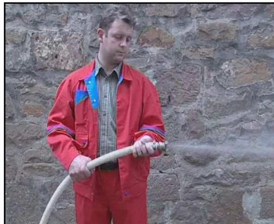
**Bild 30** – Ausblasen der Verunreinigungen aus der Gasrohrleitung mit dem Adapter und Schnellverbinder für Druckluft
