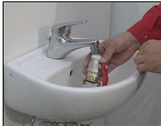
**Bild 18** – Anlagenreinigung - Armatur mit Wasserstrahl.
