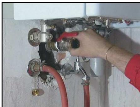
**Bild 51** – Abbau der Wartungsarmaturen
