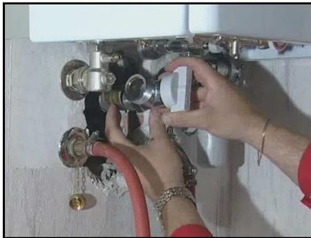
**Bild 52** – Einbau der Absperrhähne der Gasverbraucher
