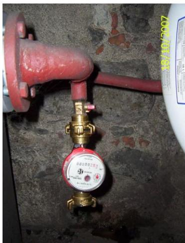
**Bild 14 - - Bestimmung der Volumenmenge im System durch Entleerung über den Wohnungswasserzähler**
