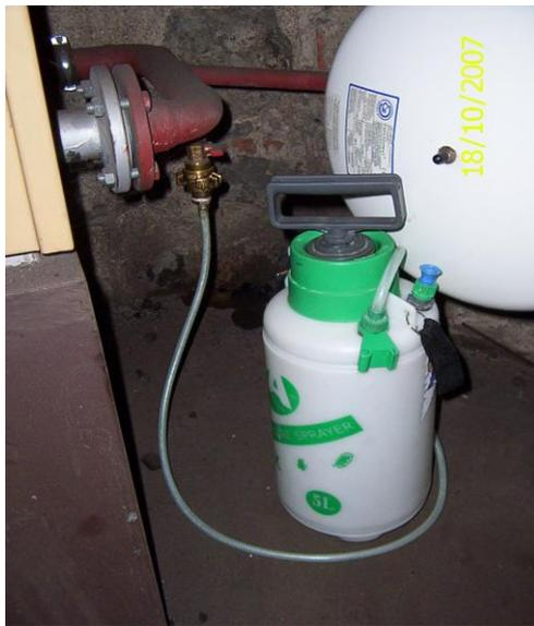
**Bild 16 – Füllung des Korrosionsinhibitors in das System**
