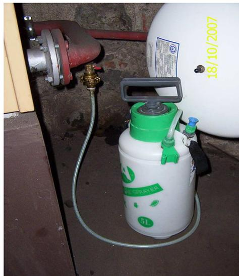
**Bild 18 – Füllung der Flüssigkeit in das System**
