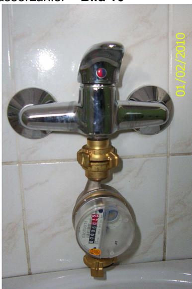
**Bild 16 – Bestimmung der Volumenmenge im System durch Entleerung über den Wohnungswasserzähler**
