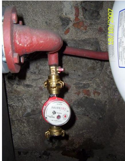
**Bild 8 – Bestimmung der Volumenmenge im System durch Entleerung über den Wohnungswasserzähler**
