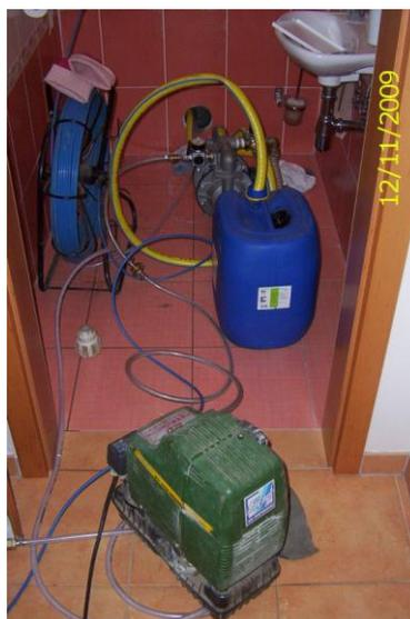
**Bild 10 – Füllung der Flüssigkeit in das System**
