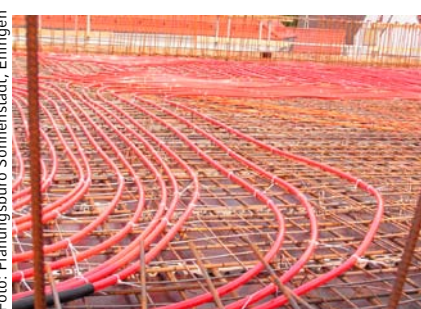
Vorbereitung einer Betonkernaktivierung Decke/Boden
