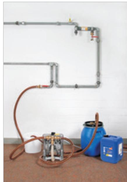
3. Dopo aver eseguito e terminato a regola d'arte il riempimento si deve pressurizzare la tubazione con 4 bar, aggiungendo eventualmente 1 bar per ogni 10 m di altezza dell'installazione da sigillare. In questo modo il sigillante viene pressato nei raccordi filettati non a tenuta.
